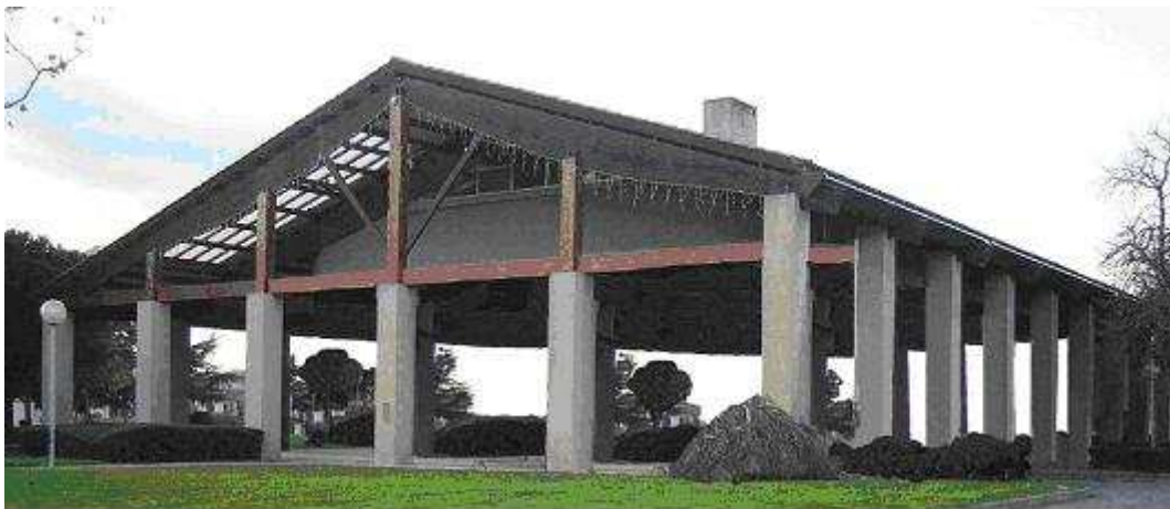
A-t-on évalué d'autres solutions que la démolition pour la salle des fêtes ?
