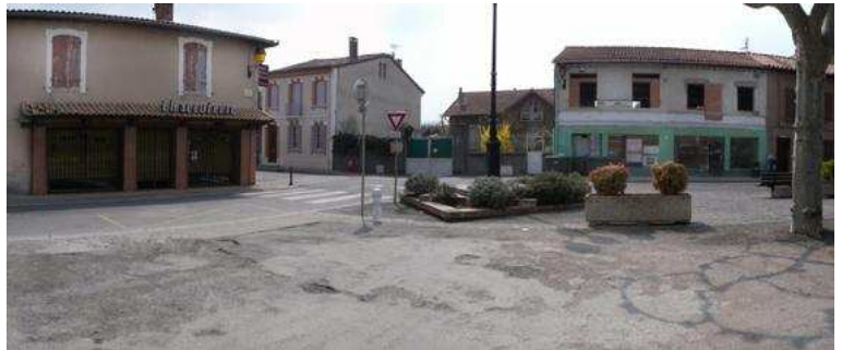
La place Verdier a été désertée par les commerces de bouche. Sa revitalisation passe par une continuité depuis l'avenue des Pyrénées
